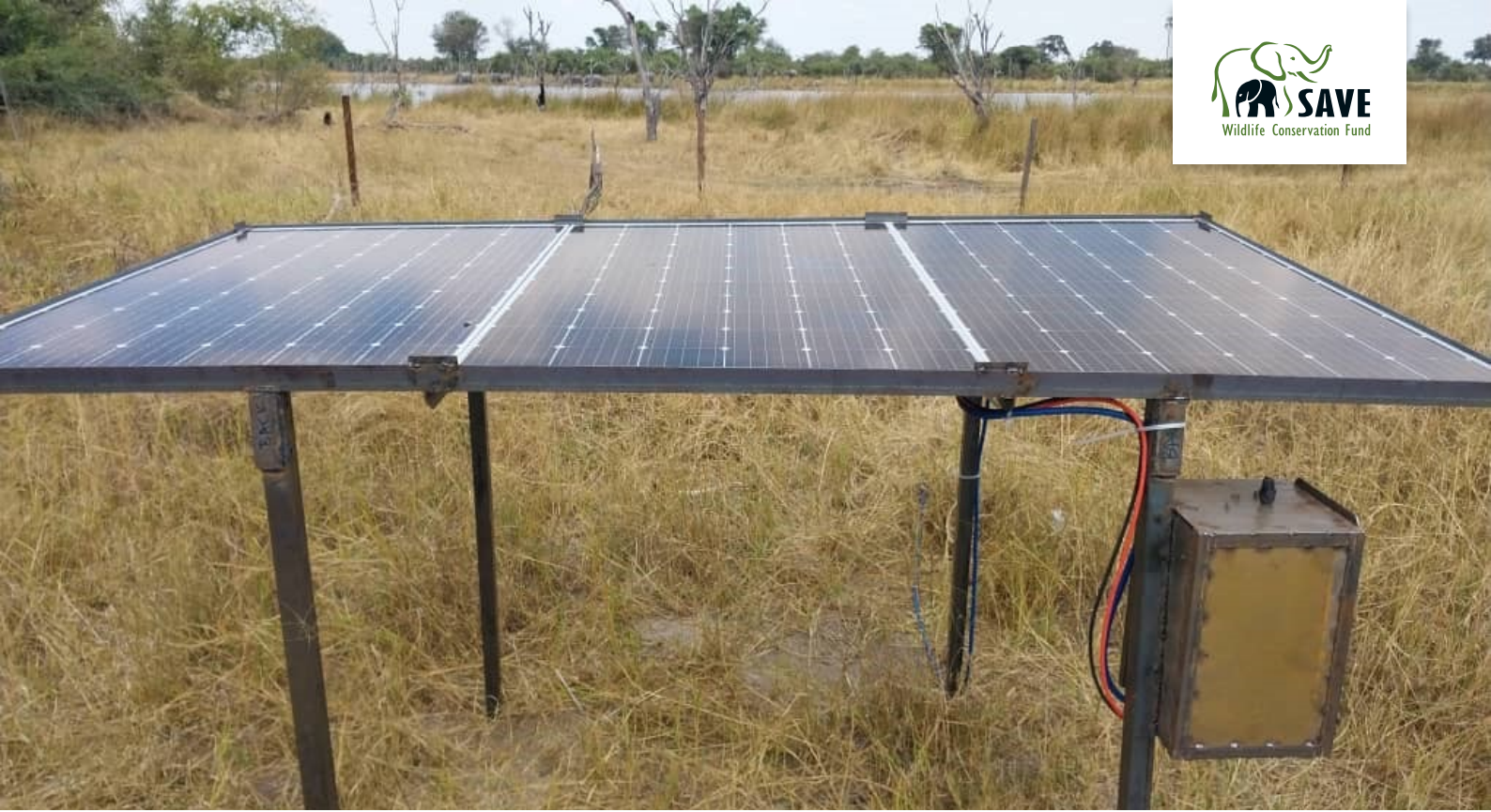
Solaranlage zur Bewässerung des Gemüses
